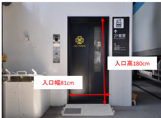
車両甲板エレベーター出入口
