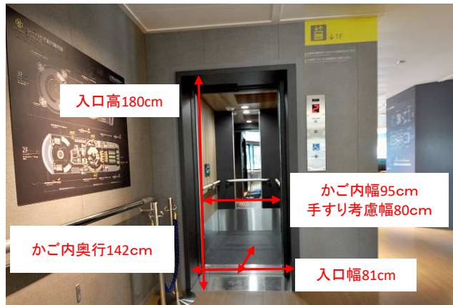
2F客室エレベーター出入口
