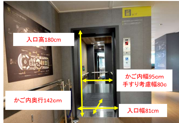
2F客室エレベーター出入り口
